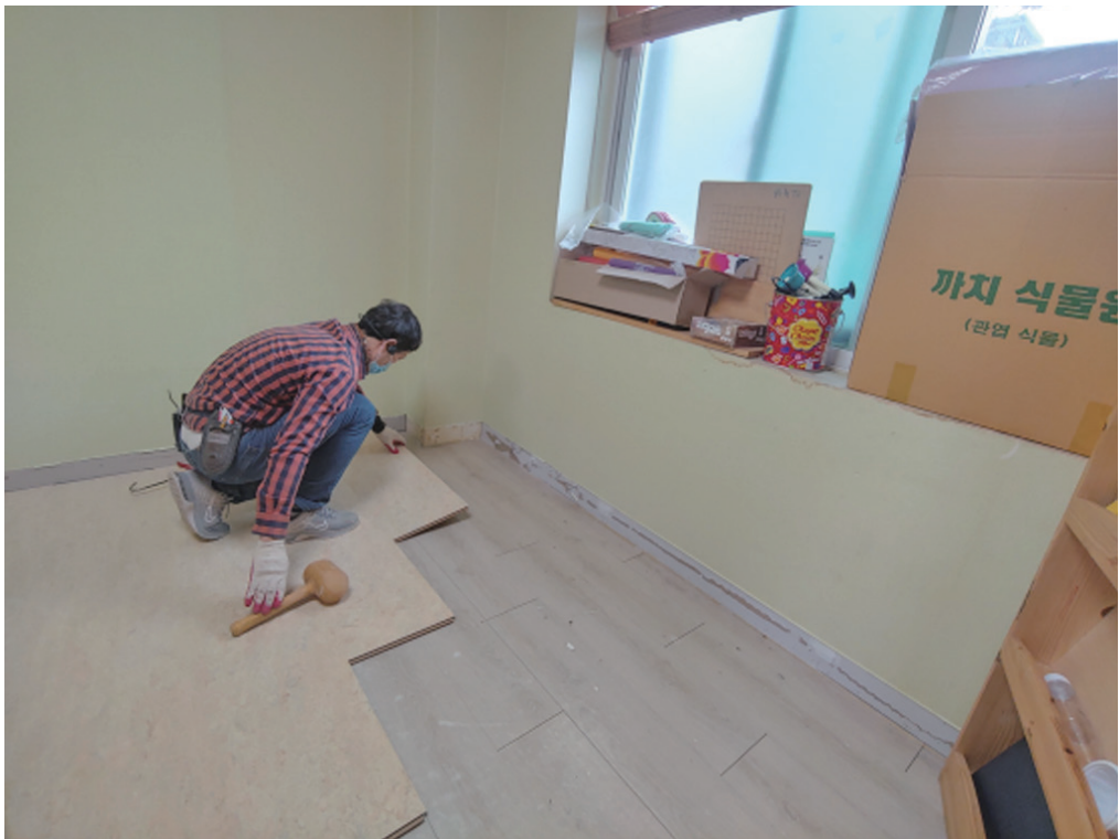
[그림 1] 친환경바닥재를 어린이집에 시공하는 모습
