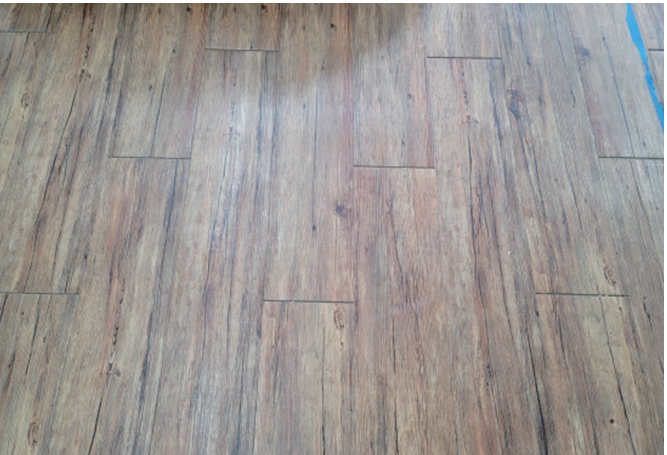
[그림 12] PVC 재질 및 중금속 함유(납, 490 ppm; 카드뮴, 320 ppm)가 확인된 바닥재
